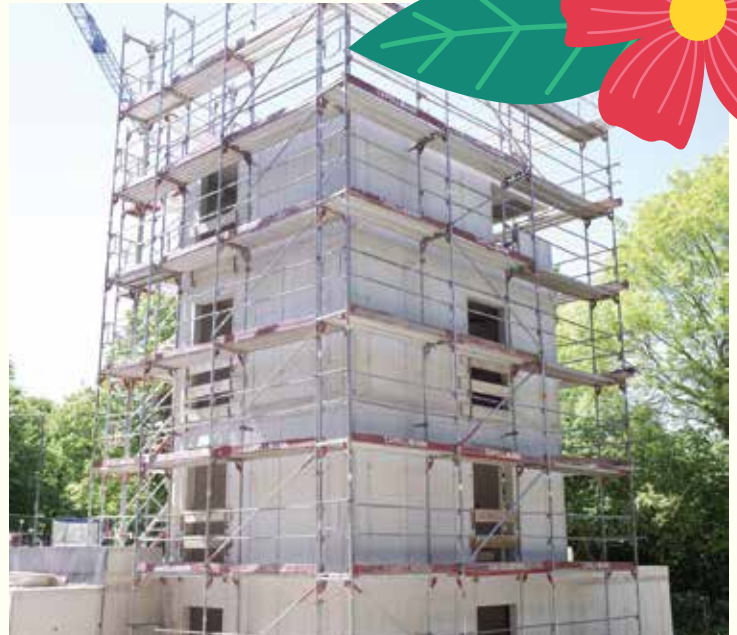
Etappenziel im Mai erreicht: der Treppenhausturm ist fertig.
